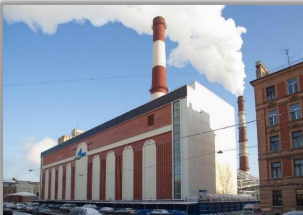
Общий вид здания ЗРУ 110/6 кВ
