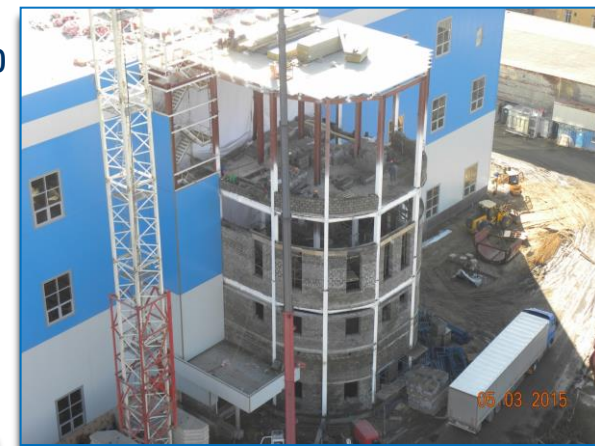
Главный корпус ГТУ ТЭЦ
